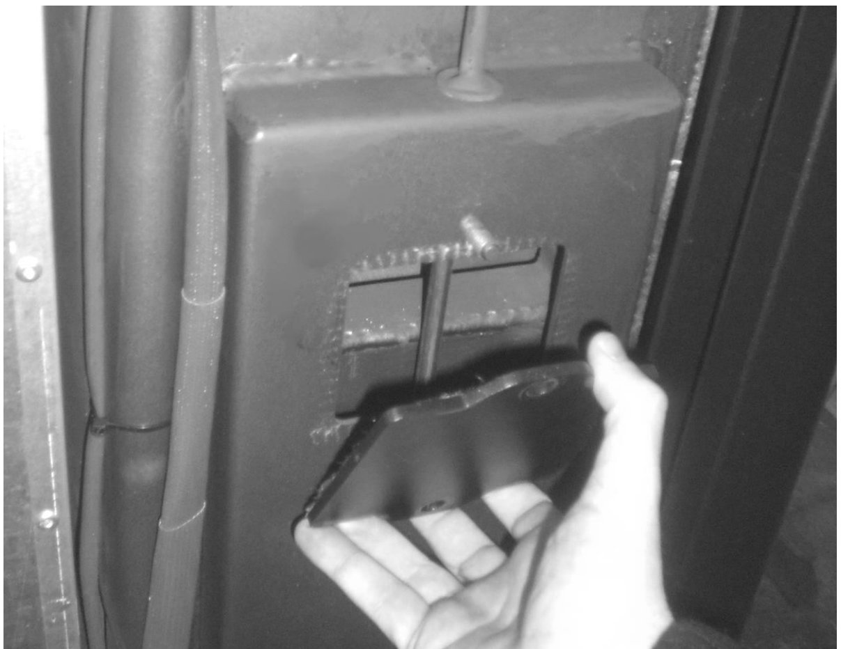
Отвинтив два болта, снять крышку смотрового отверстия бокового дымового канала (пеллетная секция).
