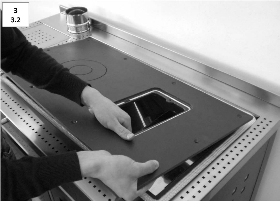
Демонтировав верхний патрубок для чистки, снять варочную поверхность, открутив десять винтов вокруг него.
