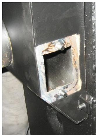
Рисунок 10 – Отверстие для чистки адаптера дыма
