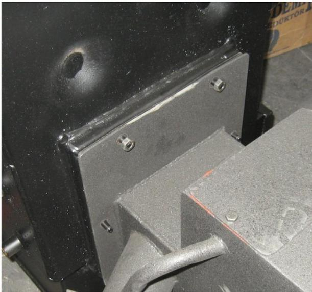
Рисунок 17 – Установленный на котле корпус шнековой подачи.
